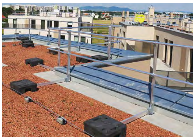
Sicherheitsgeländer selbsttragend Standard als Dachrandsicherung
