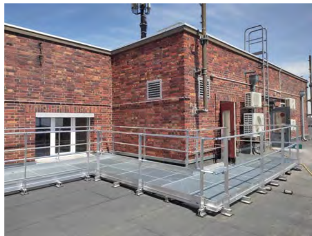
Durchdringungsfreie selbsttragende Konstruktion
